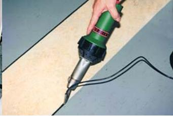
Сварочный аппарат ТРИАК S с насадкой быстрой сварки при сварке линолеума.
