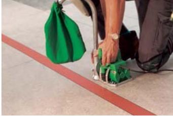
Электрофреза ГРУВЕР скользит на трех роликах и при высокой скорости обеспечивает постоянство глубины расшивки шва. Фреза позволяет расшивать швы даже в толстых и вязких напольных покрытиях из ПВХ, ПЭ и в линолеуме.
