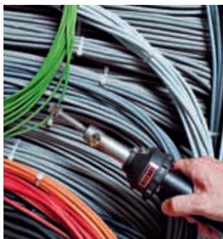
HOT JET S с решетчатой рефлекторной насадкой при установке термоусадочной муфты.
