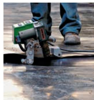
TWINNY T с комбинированным клином при сварке геомембраны из ПЭНД.
