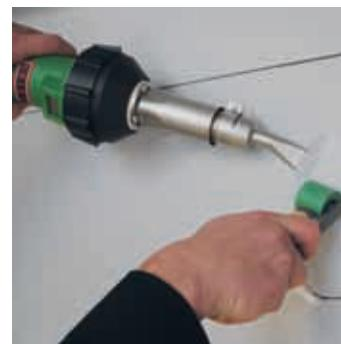
Наварка заплаты при помощи TRIAC PID на строительной площадке.
