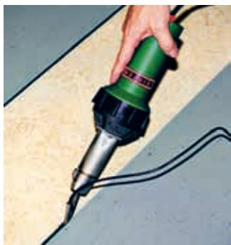
Сварка линолеума при помощи TRIAC S с насадкой быстрой сварки.
